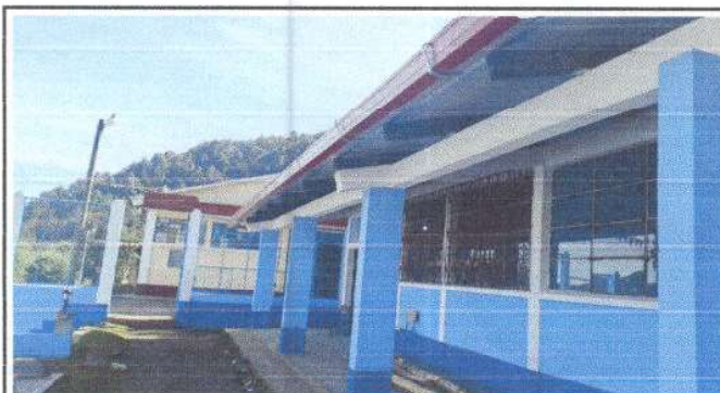
FOTO 4 Sustitución de canaletas de metal, en módulo 1.
