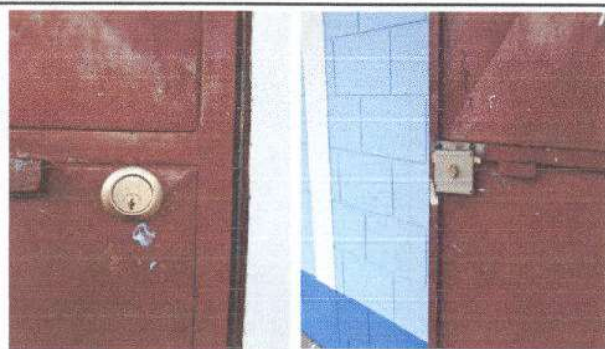
FOTO 5 Sustitución de chapas en aulas, en módulo 1.
