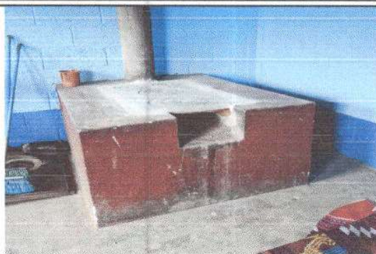
FOTO 2 Sustitución de plancha de 3 hornillas, en la cocina.
