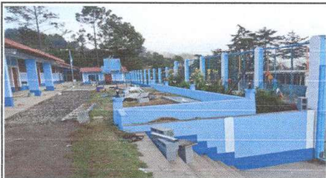
FOTO 3 Reparación de muro perimetral de block, en módulo 1.
